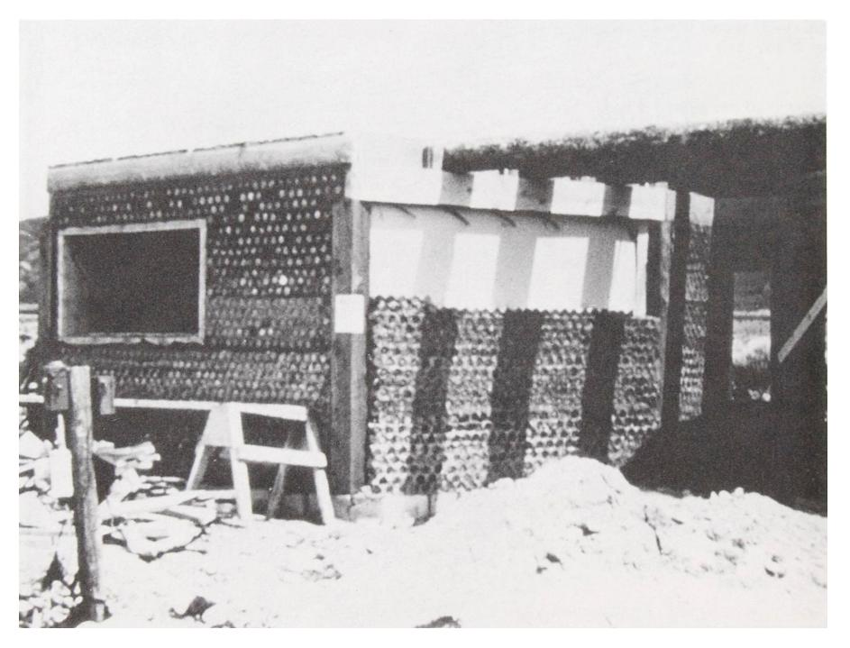
Si los paneles no van a ser revocados, las uniones entre columnas y paneles así como entre vigas y paneles deberían hacerse a prueba de climas. Se aconseja consultar a un arquitecto o contratista, ya que este detalle inicial puede resolverse de varias maneras. Depende del material utilizado para realizar la red de vigas y columnas.
